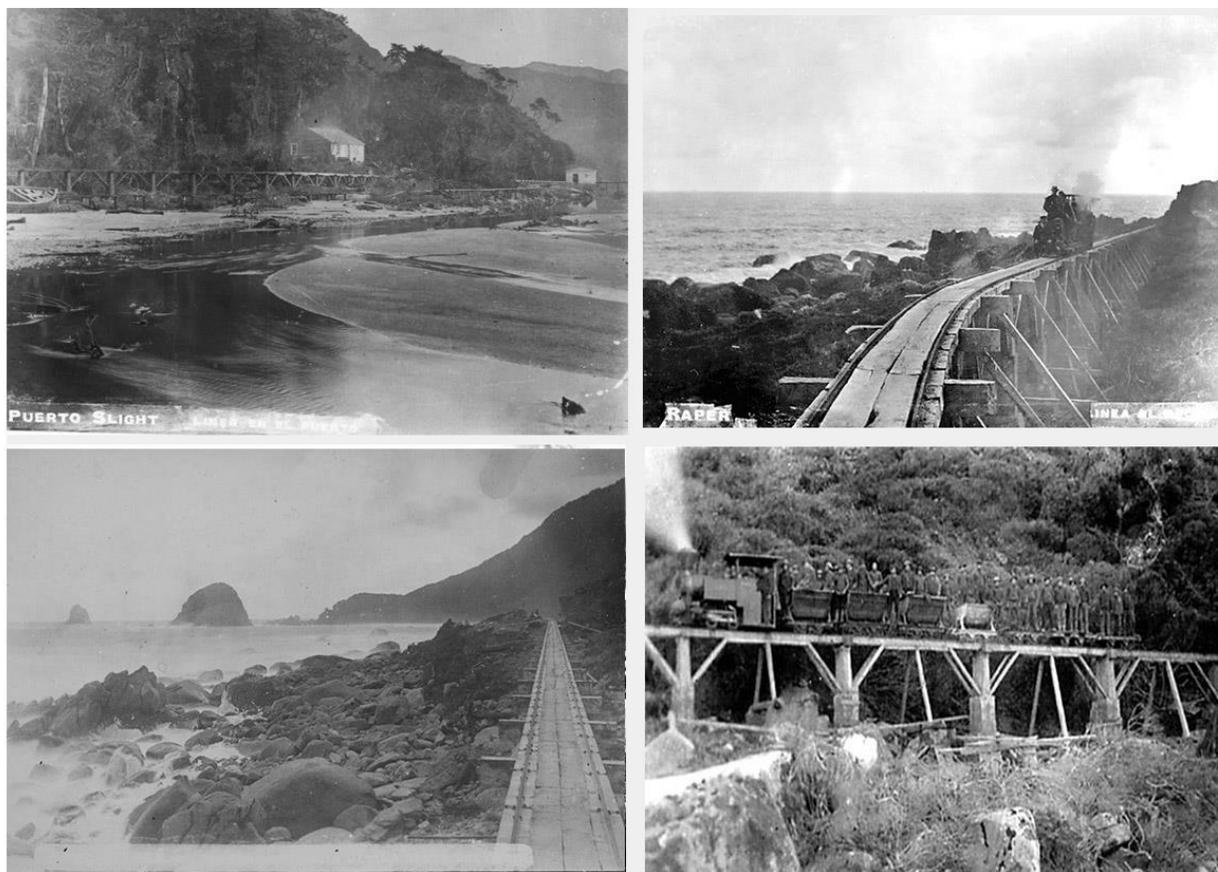
Figura 11. Imágenes de la etapa de construcción del Faro Raper y línea de abastecimiento. La primera imagen corresponde al comienzo del tramo desde Puerto Slight, y en las segundas se ve la línea ferroviaria en su camino hacia el cabo Raper. Fuente: registro de Quezada, M. (2019), para esta investigación, a las placas fotográficas originales de autoría de Georges Slight. Archivo perteneciente a la Sra. Carmen Slight Ossandón.
