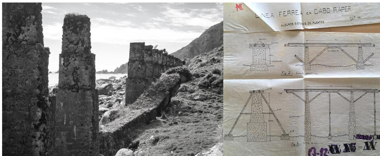
Figura 9. Fotografía que corresponde al estado actual (febrero 2019), de los pilares de concreto correspondientes a trazado de nivel de la línea en el segundo tramo de las obras, en la costa exterior de la península de Taitao. Fotografía: Maíz, Federico (2019), para esta investigación.
