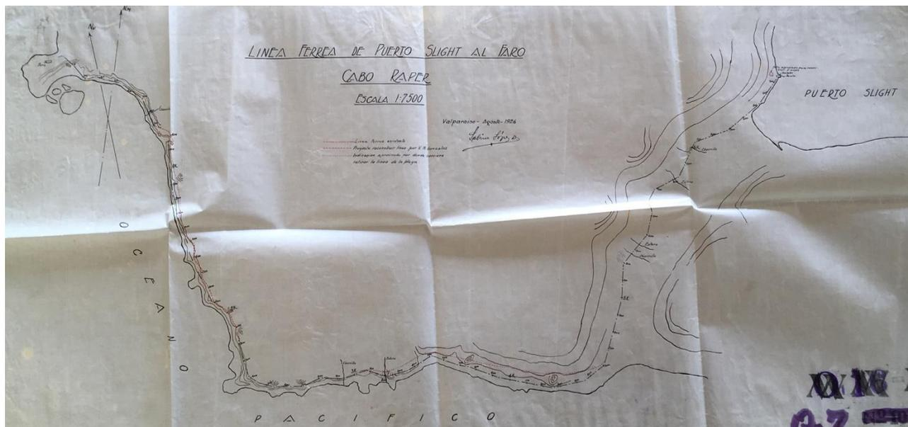
Figura 8. Levantamiento de la línea de tren realizado el año 1926 por la Armada. Muestra claramente el trazado continuo de la línea de tren, desde el muelle construido hasta el peñón donde ya en esa época el faro estaba terminado y operando. Reproducción de plano original. Fuente: Archivo Histórico Directemar.
